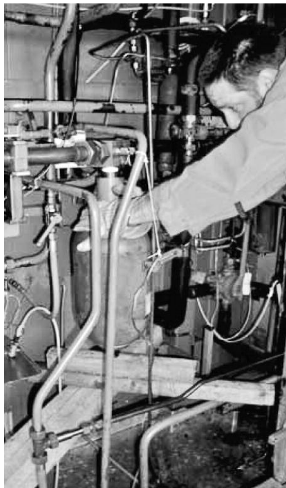
Técnico de mantenimiento realizando tareas de mantenimiento.
